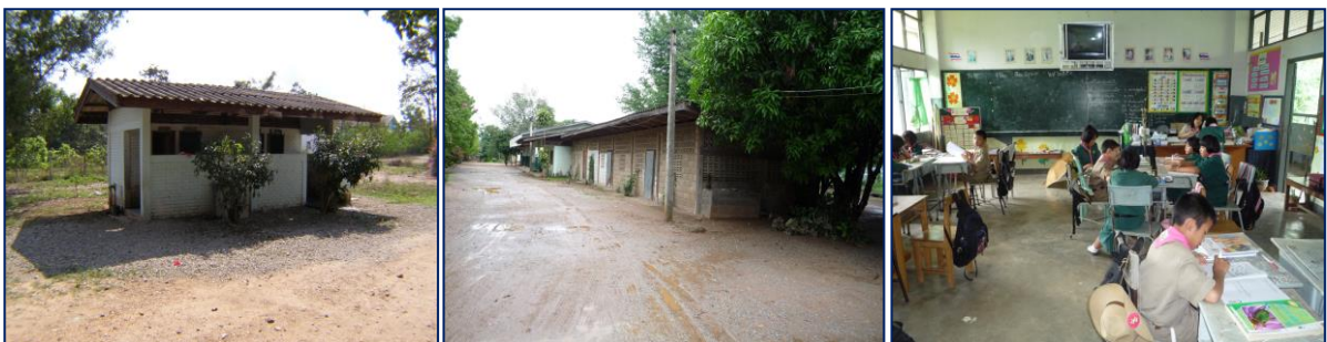
รูปภาพที่ ๒ แสดงสภาพอาคารประกอบ ห้องเรียนและสภาพสิ่งแวดล้อมก่อนการพัฒนา
